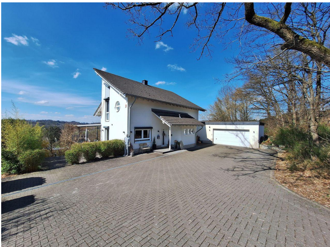
Haus - und Hofansicht
