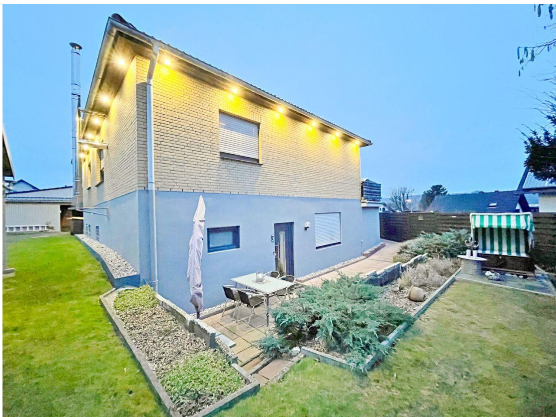
Zugang zur ELW mit Abendbeleuchtung-bearbeitet
