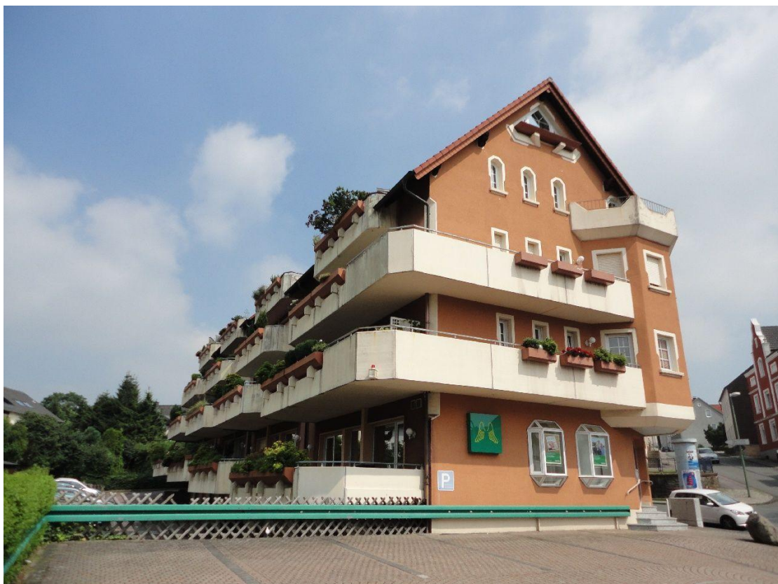
Ansicht Eingangsseite und Parkflächen
