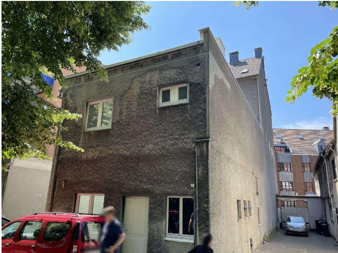
Anbau rechts mit separaten EG-Zugang
