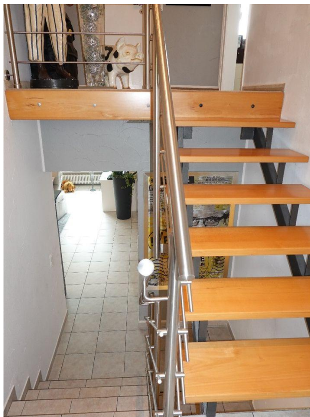
Treppenhaus mit Halbetage
