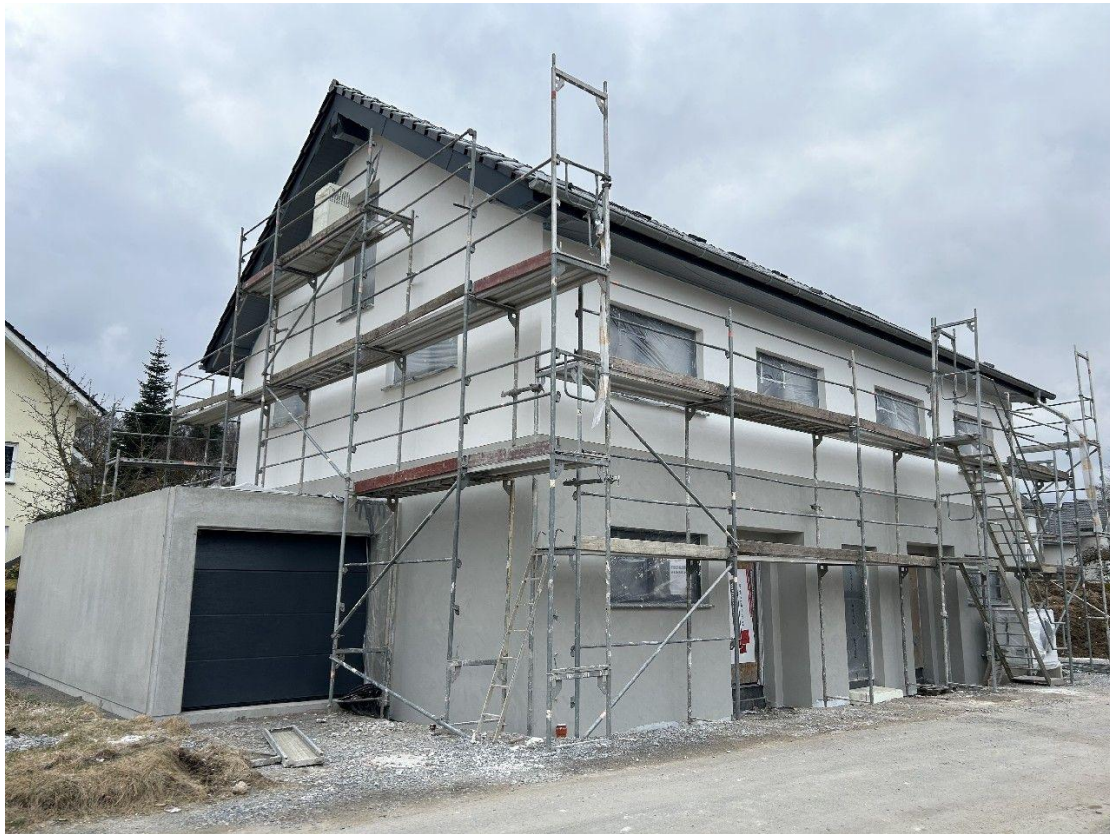
Doppelhaushälften im Bau
