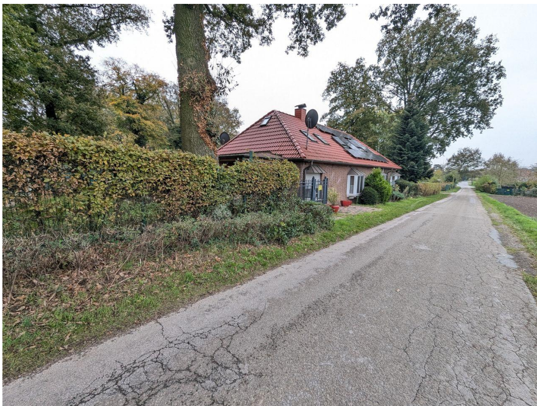
Frontansicht mit PV-Anlage
