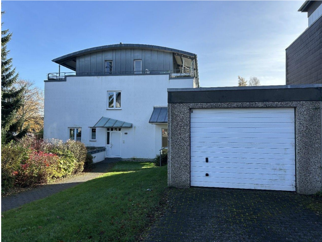
Wohnungseingang mit Garage
