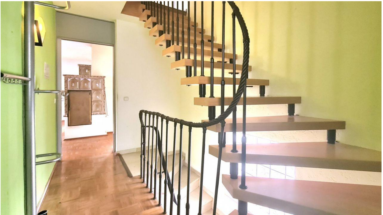
Treppe ins DG
