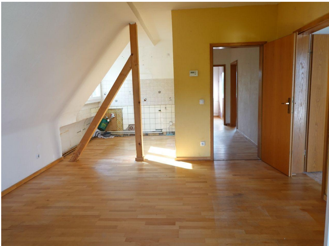
Küchenbereich mit Balkonzugang im DG
