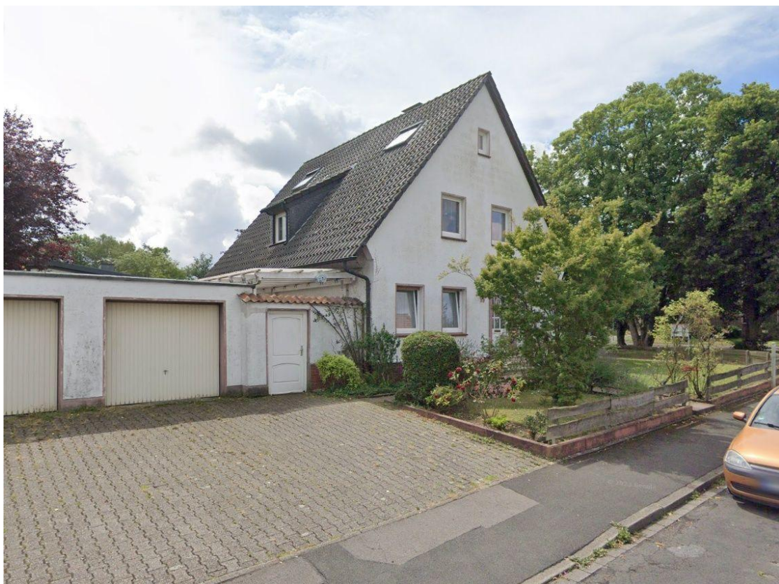
Haus mit 3 Garagen
