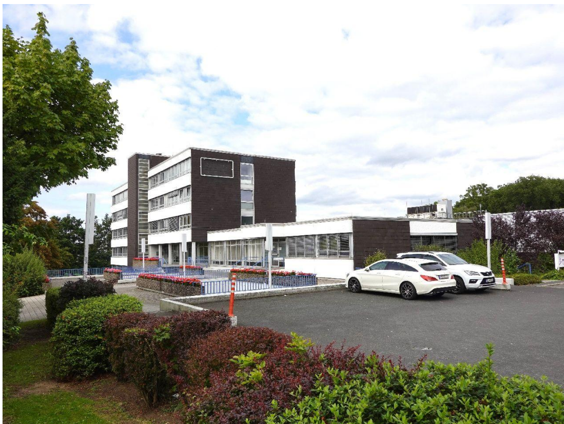
Frontansicht- Kundenparkplätze direkt vor dem Gebäude
