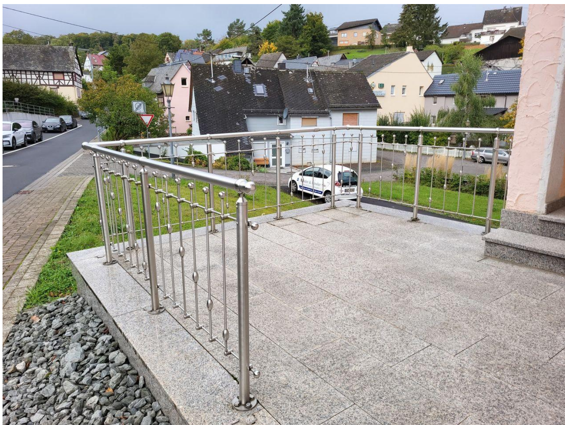
Freisitz im Eingangsbereich
