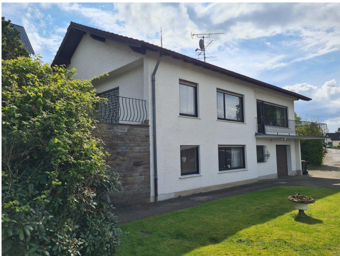
In exponierter Ortslage
