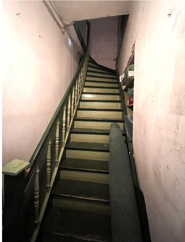
Treppe zum Spitzboden
