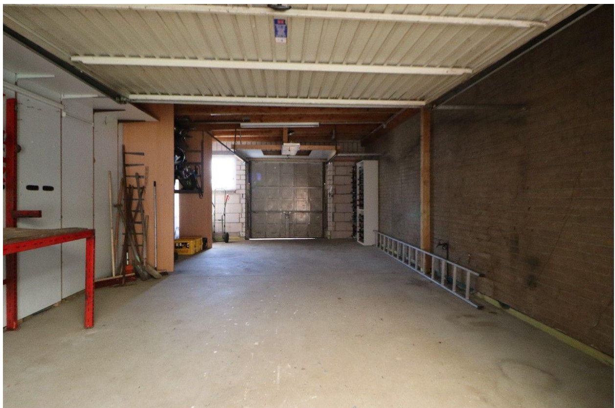
Seitlicher 40 qm großer Anbau
