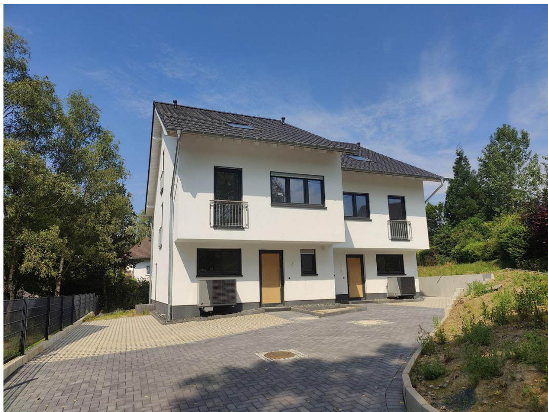
Frontansicht Haus Nr. 4b+4c
