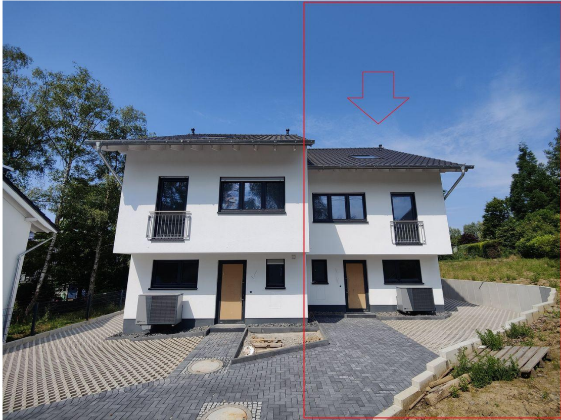
Frontansicht Haus Nr. 4b+4c
