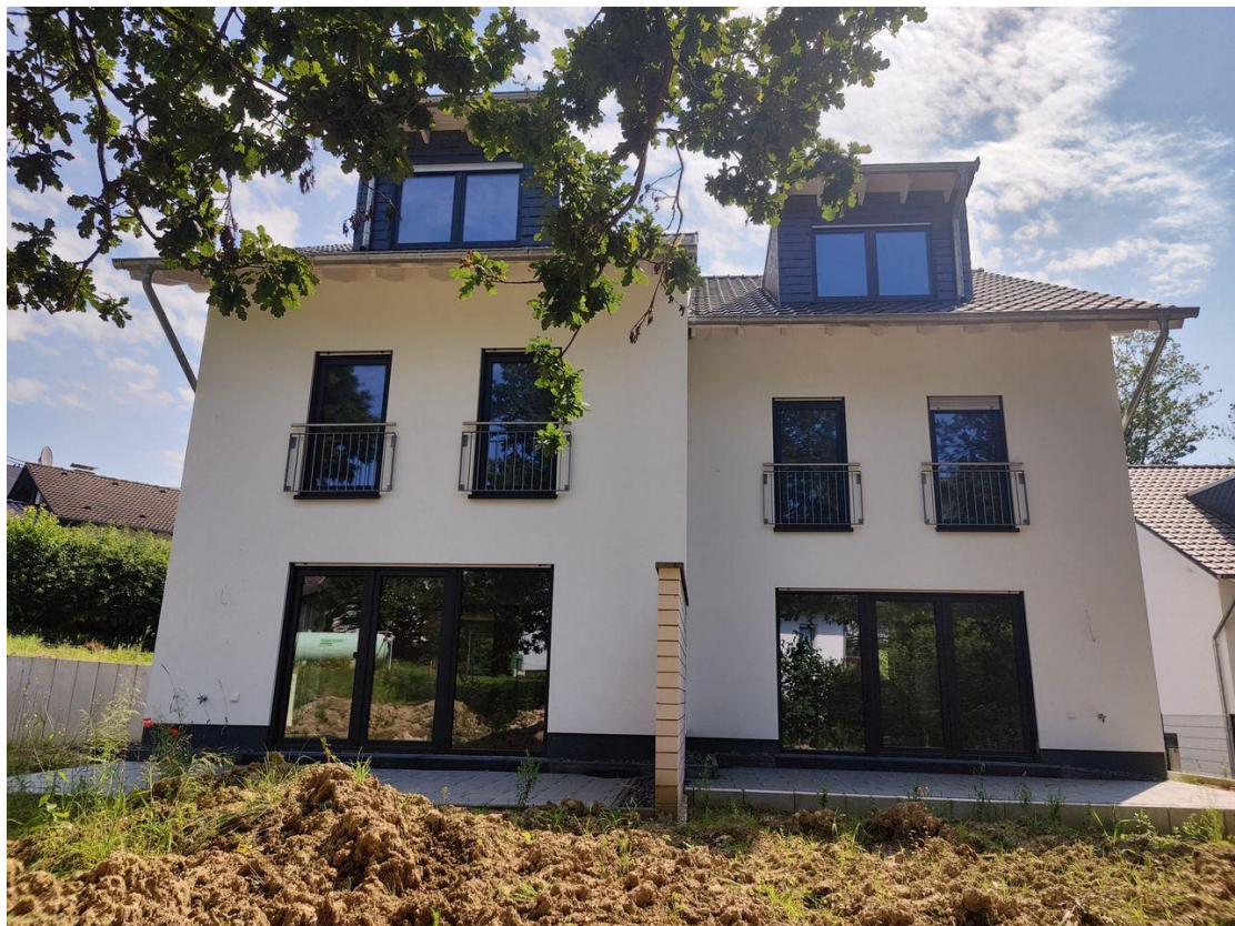
Rückansicht Haus Nr. 4b+4c
