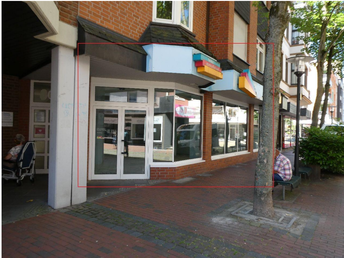
Seitlicher barrierefreier Eingang
