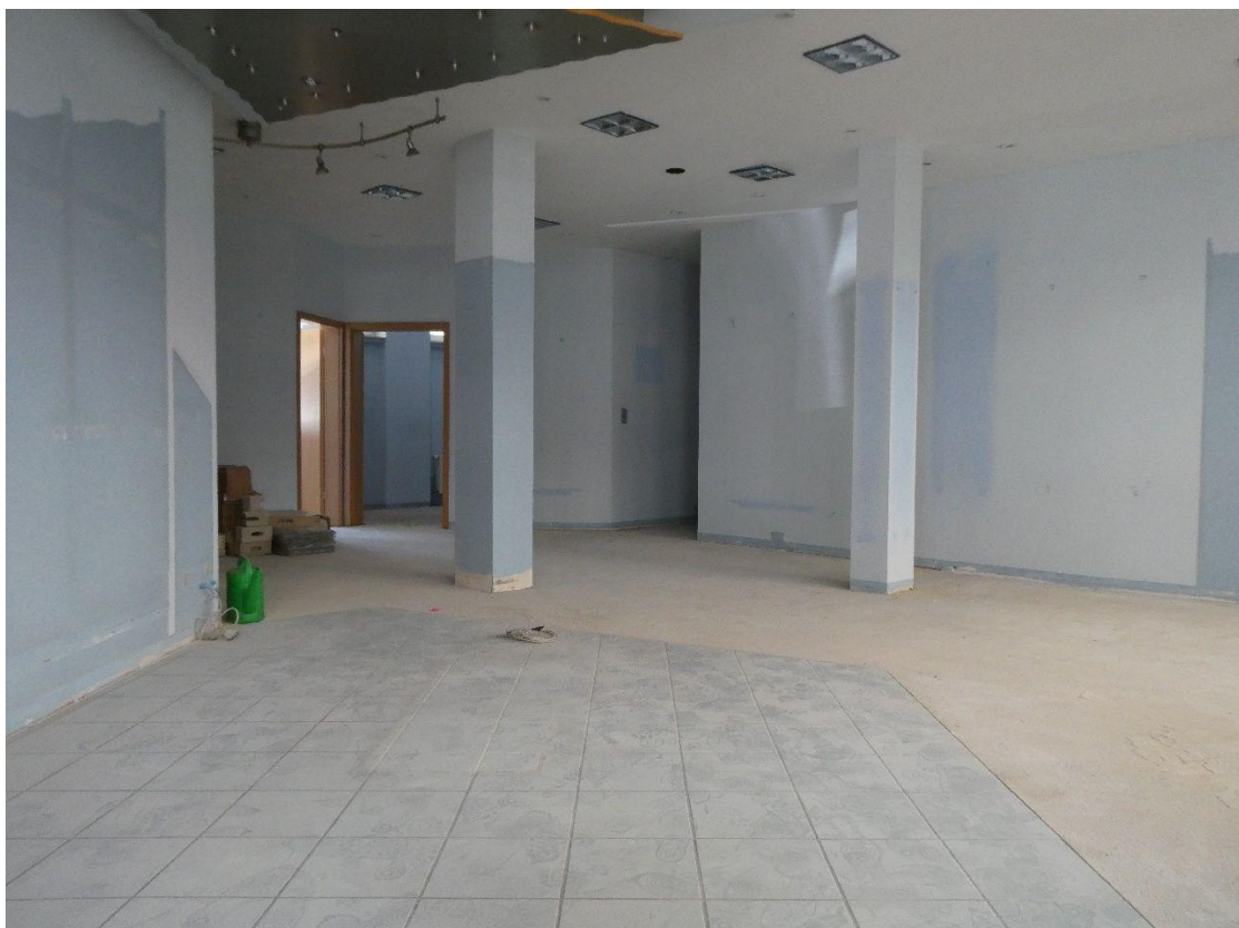
Individuelle Gestaltung durch Leichtbauwände
