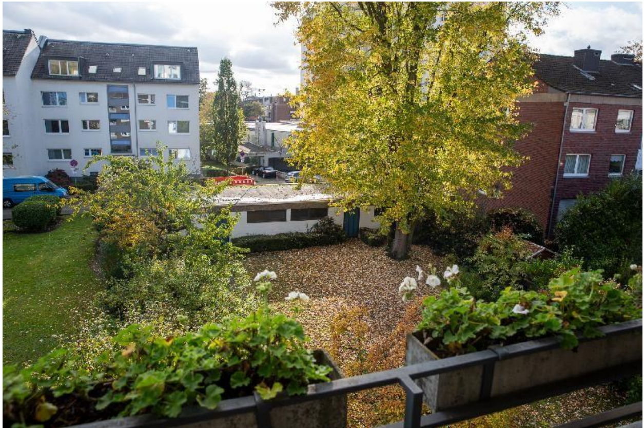
Ansicht Grundstück mit Garagenbau
