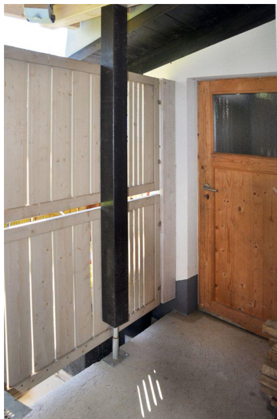
Abstellraum hinter Garage
