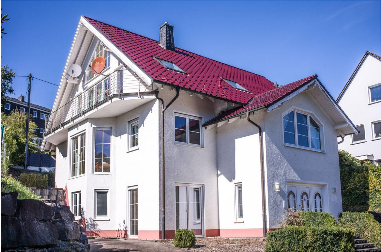
Blick von Südwest
