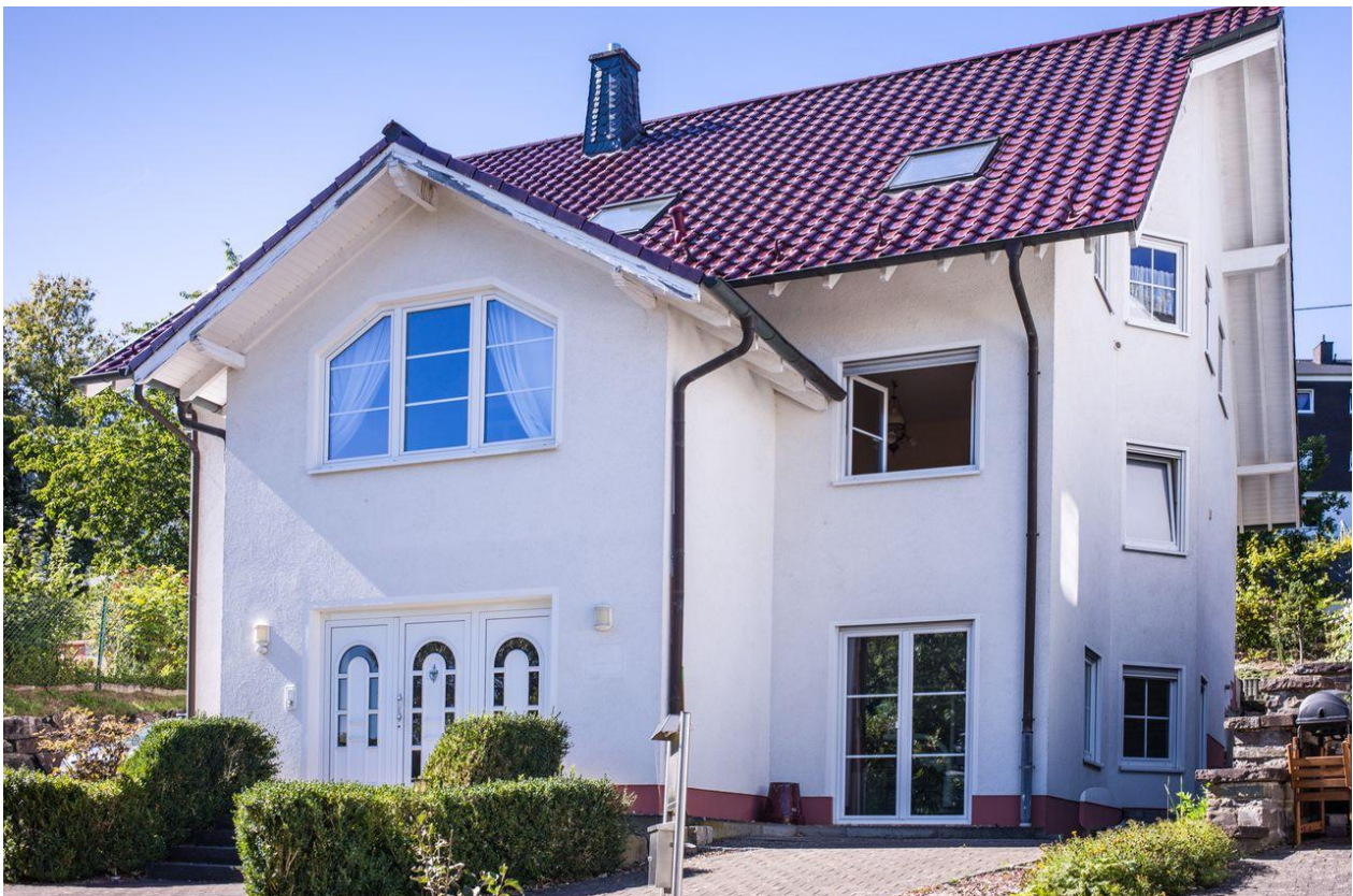
Haus mit Eingang
