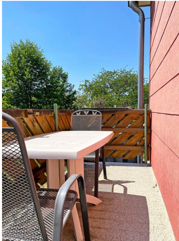
Balkon im EG - Ausgang Küche-bearbeitet
