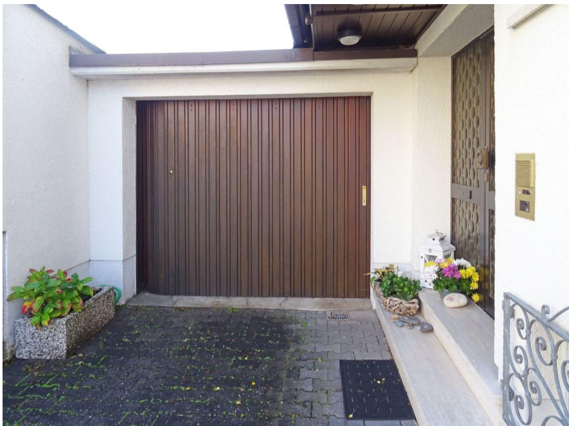
Garage mit elektrischem Tor
