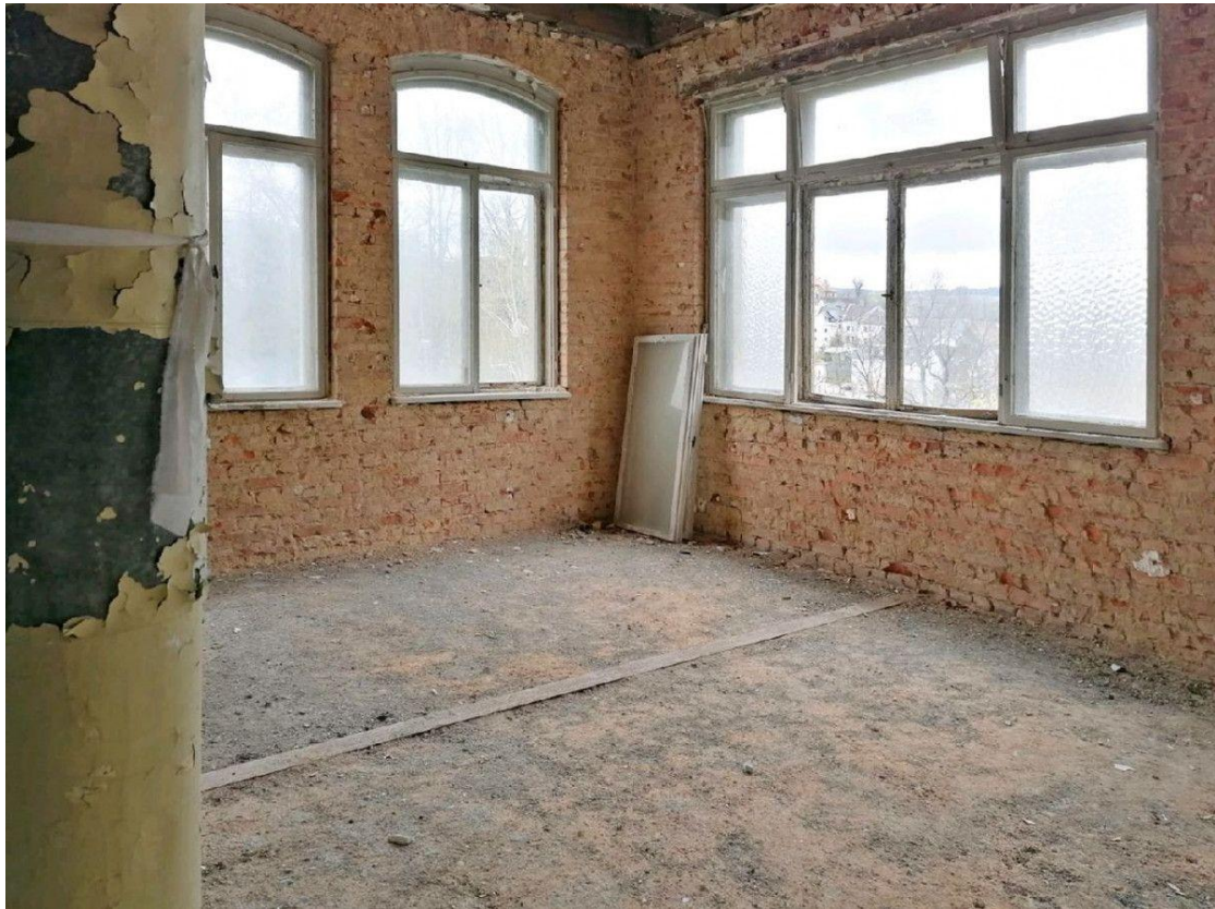
Beispiel für ein entkerntes Geschoss
