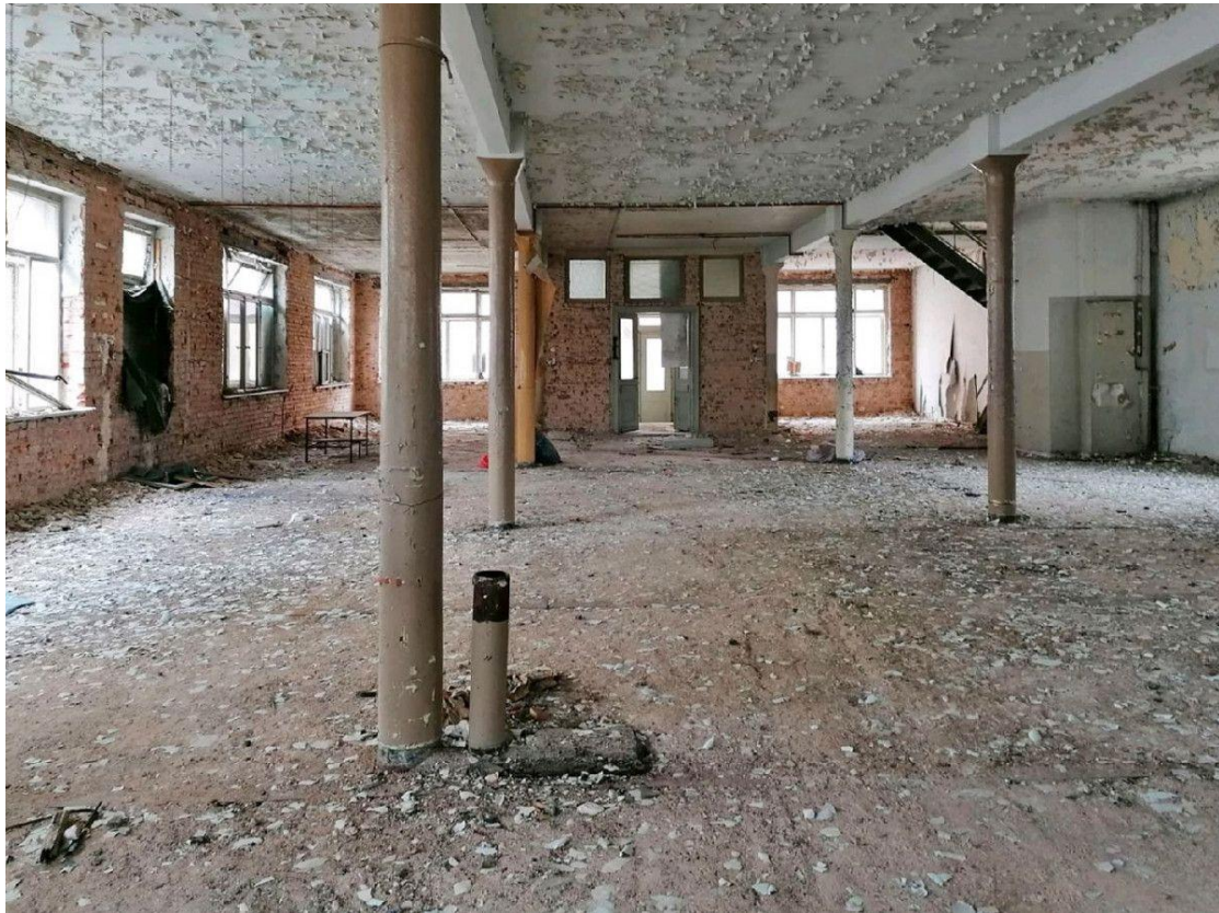
Entkerntes Erdgeschoss
