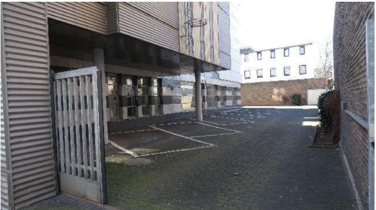
Innenhof mit PKW-Stellplätzen
